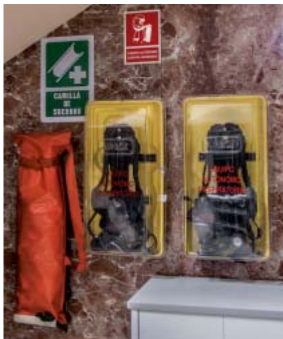
Sistemas de protección/ Protection systems
